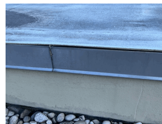
Roof 2 - South edge
