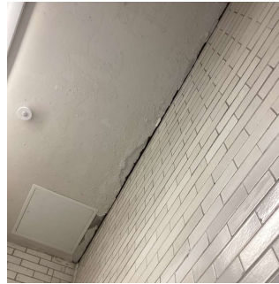
Girls Toilet Room
