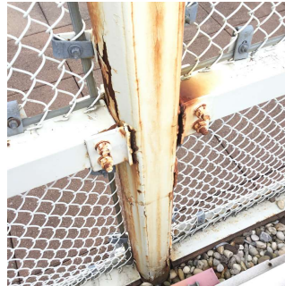
Roof 1 -Plaza Deck
