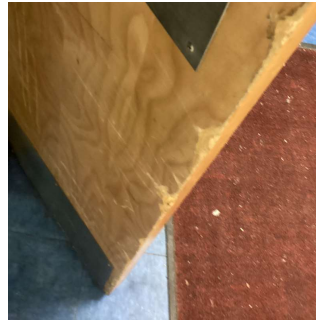
Stair H/1 Vestibule (2 Doors)
