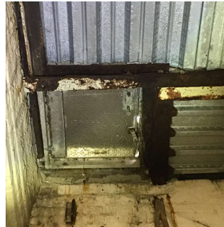
Sub-Basement - Escape Door
