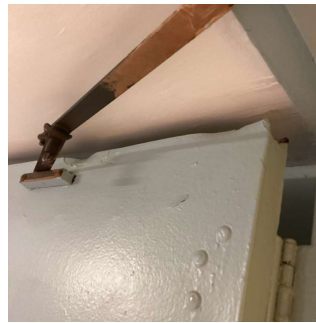
Stair F/1 Vestibule
