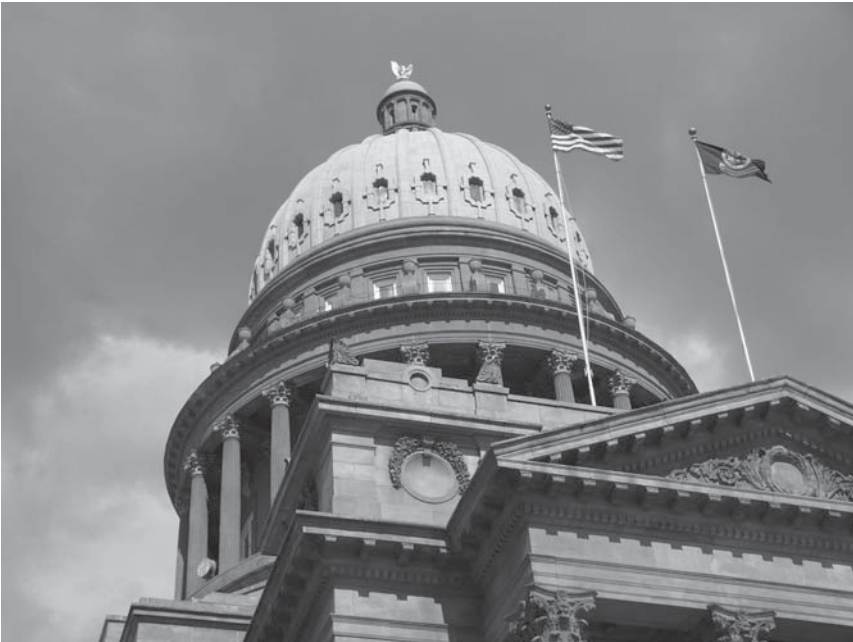
Capitol Dome Exterior
