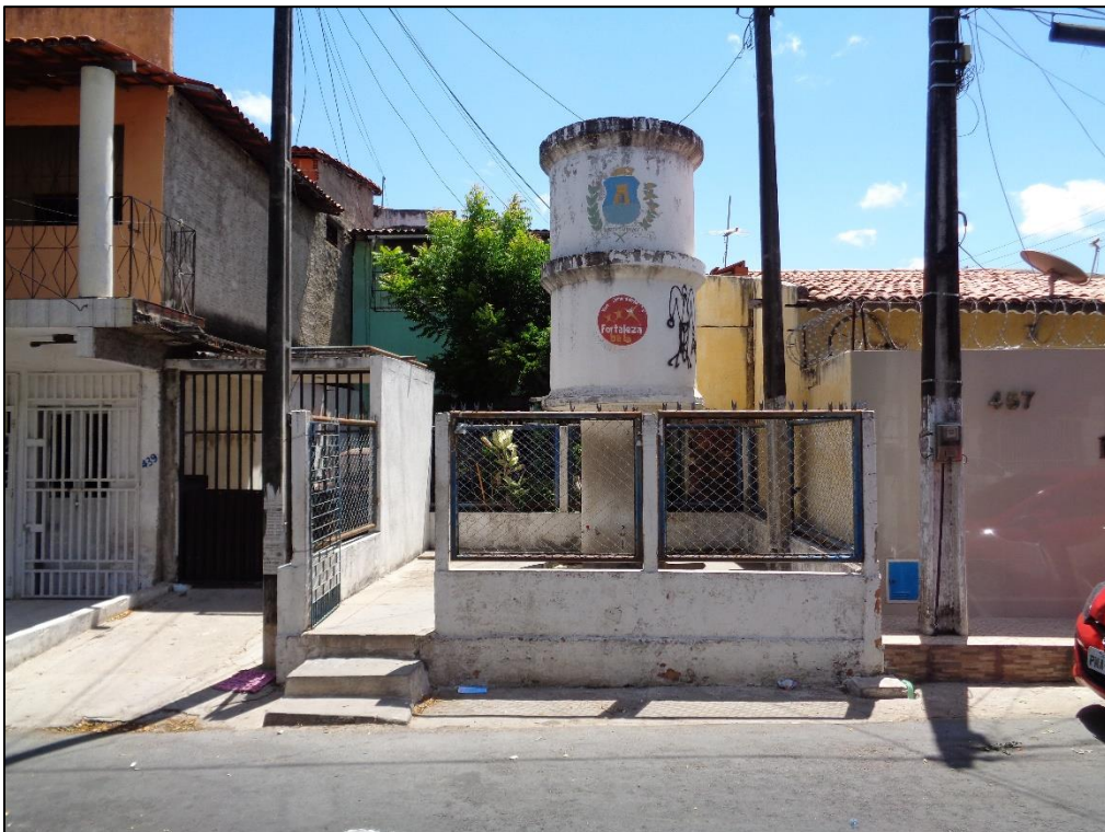
Figura 8.1.3 – Proteção no entorno do chafariz.
