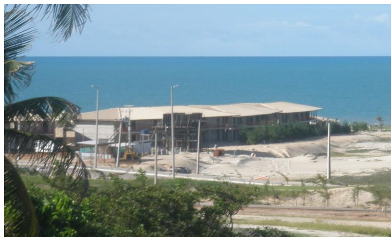
Figura 8.11 – Fase de construção do Hotel Dom Pedro Laguna no complexo Aquiraz Riviera
