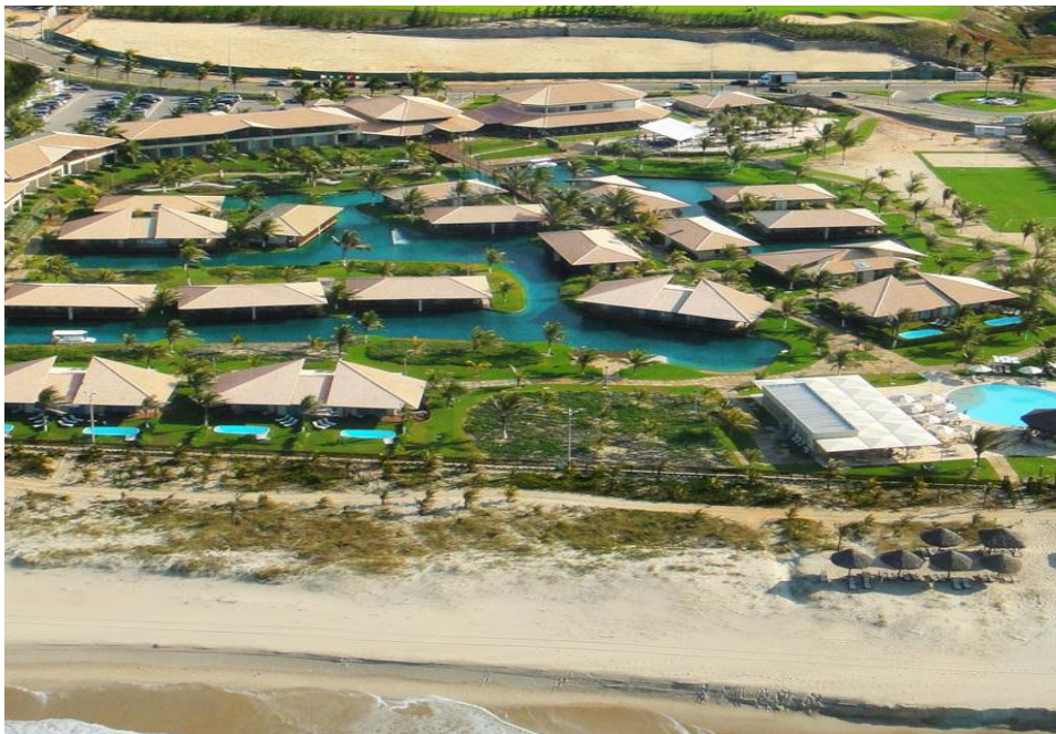
Figura 8.13 – Hotel Dom Pedro Laguna finalizado
