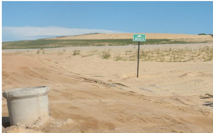
Figura 8.9 – Terraplanagem do complexo Aquiraz Riviera
