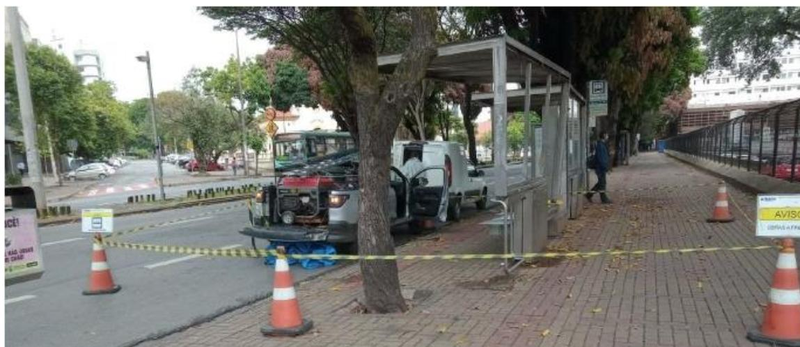
O Plano de manutenção da empresa GP Comércio e Distribuidora de Mobiliário Ltda consiste basicamente na manutenção para a reforma dos abrigos existentes. Os serviços corretivos executados são do tipo substituição da cobertura e pintura da estrutura.
