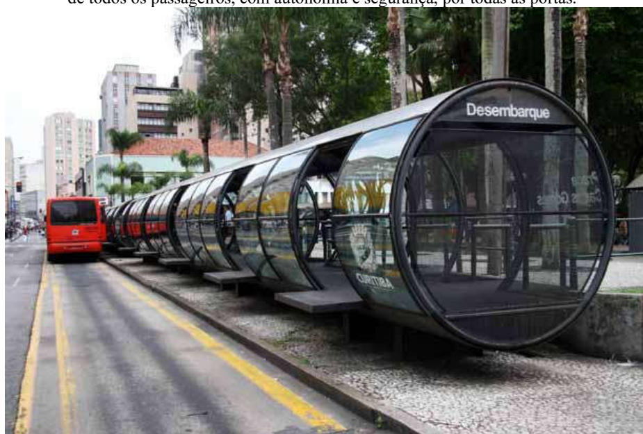
Figura 2 - plataformas de uma estação-tubo do sistema de transporte público de Curitiba, vendo-se ao fundo um ônibus do nível 10 da escala IAED parado para permitir o embarque/desembarque em nível de todos os passageiros, com autonomia e segurança, por todas as portas. 36
