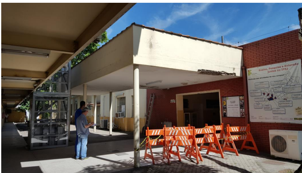
Figura 1: Pórtico a ser demolido, Campus IFRJ-Volta Redonda, RJ.
