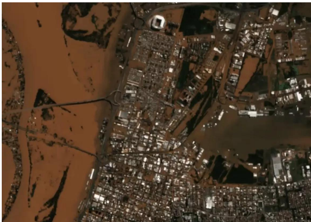
Figura 26 - Região do 4º Distrito, depois da inundação da enchente de maio/2024
