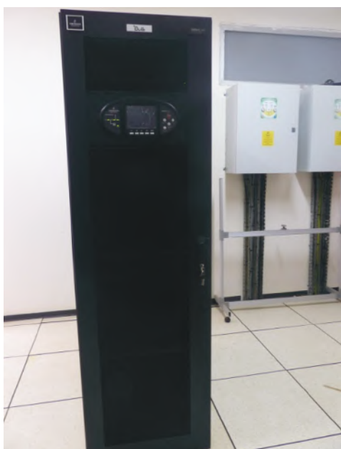
Centre de traitement de données
