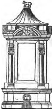
Lamb's Conduit, Snow Hill.
