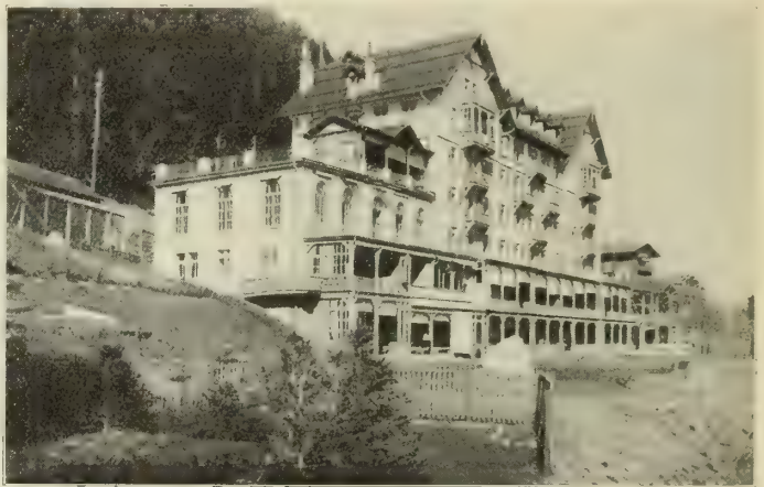
Sanatorium des Alpes vaudoises à Leysin. D'après une photographie.
