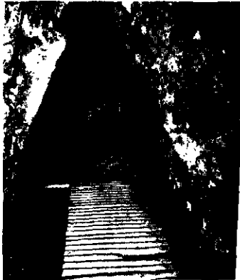
קטע מספער-המים של אחאב במגידו: מנהרה חצובה בסלע (האורך: 70 מטר, הנובה: 3 מטרים) — המאה ה-9 לפסה"נ (ברשות המכון ללימודי-המזרח באוניברסיטת שיקגו)
