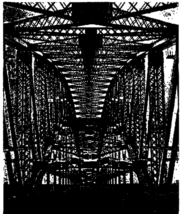
18 טראה כללי של סופות המיסבך (הקשת), קשריו ומימעת-הכביש בגשר נמלי-ירדני, אוסטרליה (בעל מיפתח של 508 מ')
