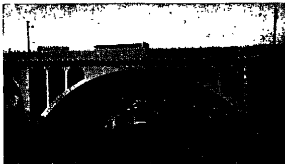
16 הקשת הראשית בגשר וארירוסטיה בחיפה בסיפחה של 30 מ' - הקשת הארוכה ביותר בגשרי א"י; אורך הגשר ככלל, בנוי בסוף מזויין - 90 מ', נבנה ב-1827
